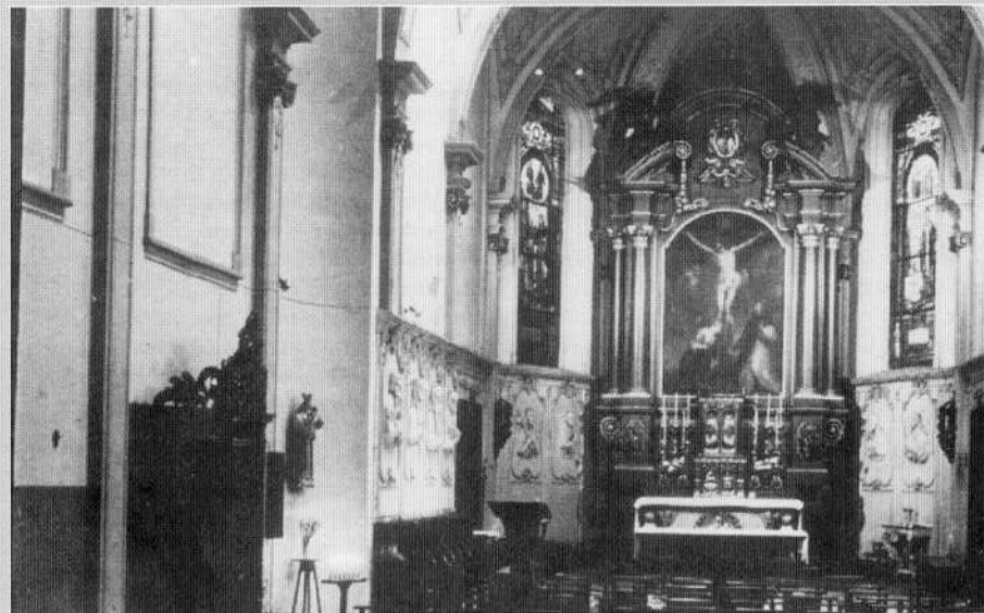
De Kruisherenkerk te Maaseik. Zicht op priesterkoor en barokke altaar. Van de vier zuilen van het altaar zijn er twee naar achter geschoven, terwijl het baldakijn vervangen werd door een gebroken boog van drie segmenten. De ranke pilasters in de kerk eindigen in een Ionisch kapiteel, waarvan de dekplaat op halve grootte, de kans biedt voor een tweede, onversierd kapiteel. Inzake stijl sluit de kerk het meest aan bij de Duitse sacrale rococo: kerken met een simpele, onopgesmukte buitenkant, terwijl het interieur fraai versierd wordt door stucwerk en omlijstingen, die de aandacht naar het plafond moeten richten. Grote ramen zorgen ervoor dat een stroom licht de kerk binnenvalt.
